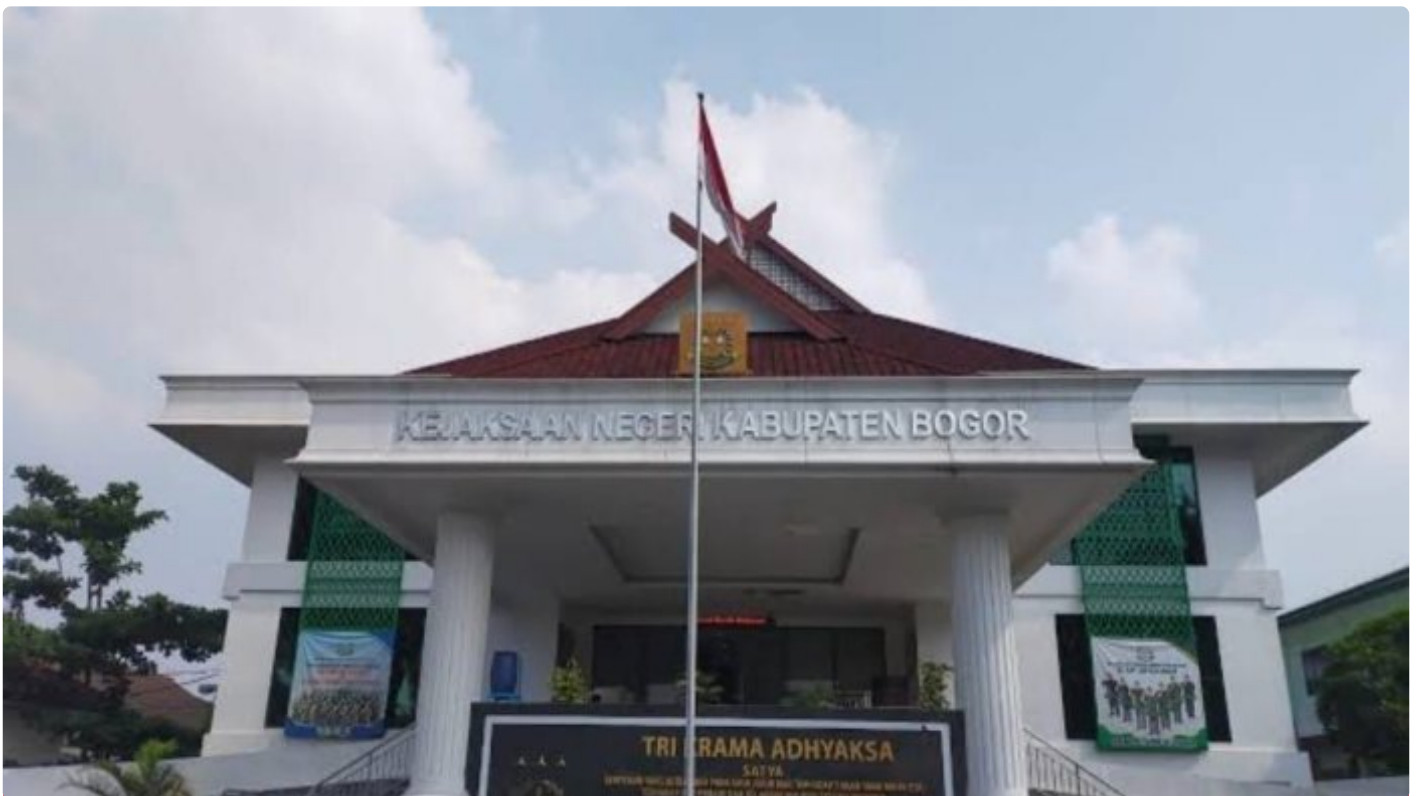
Photo: Gedung Kejari Kabupaten Bogor
